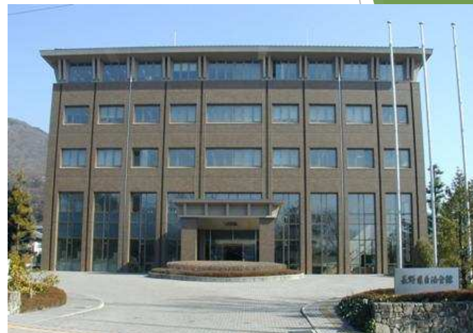
長野県自治会館外観
