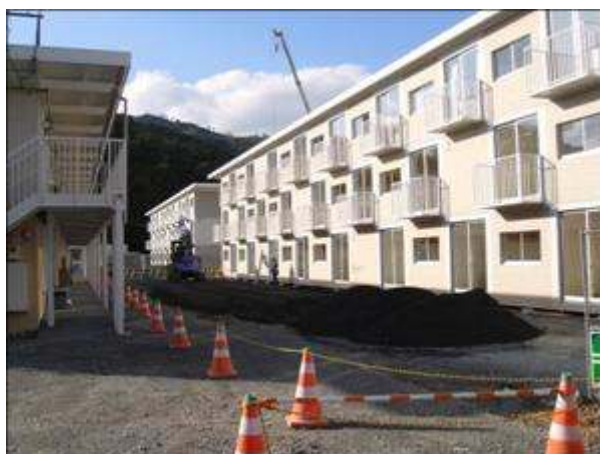
図 3-25 3階建てコンテナ仮設住宅
