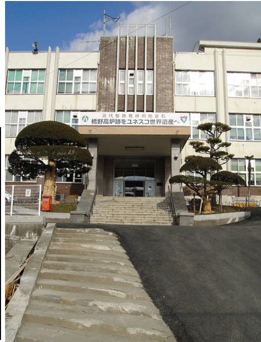
（釜石市役所第1庁舎、訪問時撮影）
