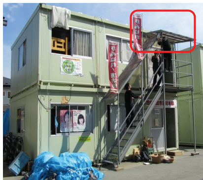
(左：市災害対策本部のある学校給食センター裏に設置された衛星通信回線用アンテナ、 中央：仮設消防本部に設置された指向性アンテナ、右：ユニットハウスに設置された指向性アンテナ 名古屋市提供資料)
