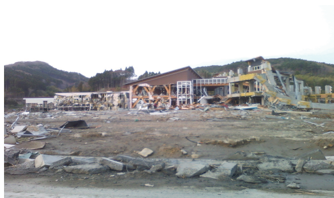
(津波の直撃を受けた北上総合支所、石巻市提供写真)
