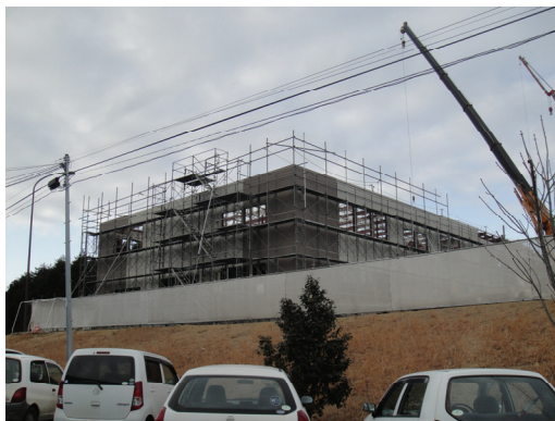
(建設中の庁舎、訪問時撮影)
