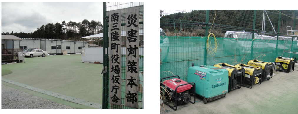
(左：南三陸町役場仮庁舎、右：テニスコート内に置かれた非常用発電装置、訪問時撮影)
