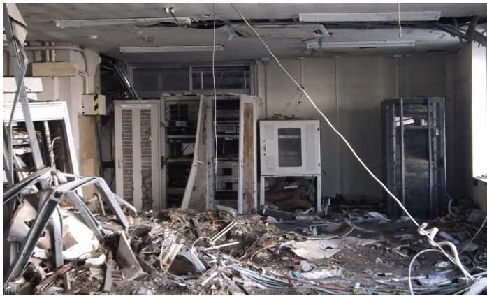
(被災したサーバ室、陸前高田市提供写真)
