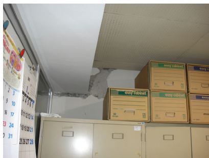
(情報政策課会議室内の壁面のひび割れ、訪問時撮影)
