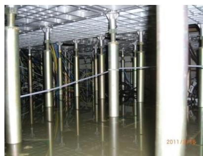
（左：本庁舎サーバ室、右、本庁舎フリーアクセスフロア内浸水の様子、石巻市提供写真）
