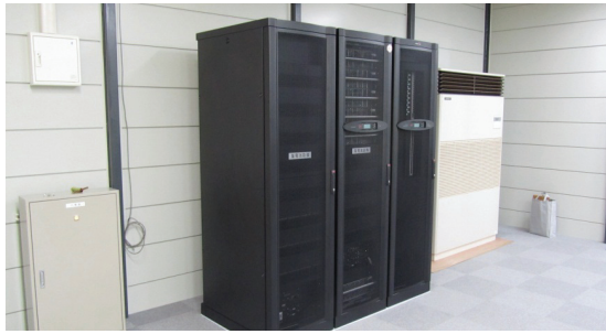
(左：仮庁舎サーバ室の無停電電源装置、右：同室内サーバラック、名古屋市提供写真)
