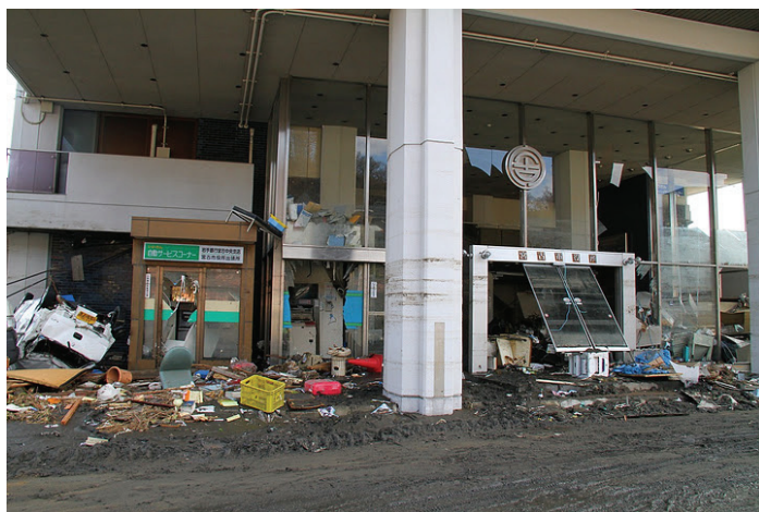
(津波が引いた後の本庁舎外観。3 月 12 日 12:00 撮影、宮古市提供写真)
