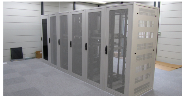
(左：仮庁舎サーバ室の無停電電源装置、右：同室内サーバラック、名古屋市提供写真)
