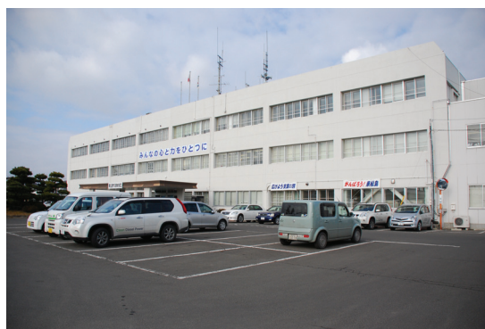
（東松島市本庁舎、東松島市提供写真）
