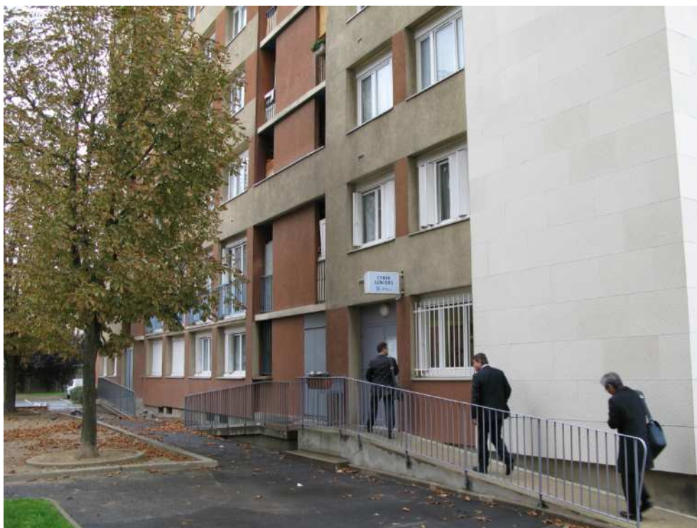
サイバーシニア建物外観
